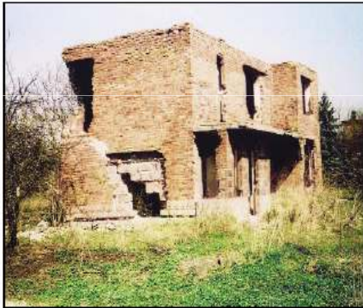
Knurów (kop. „Szczygłowiec”); zniszczony na skutek szkód górniczych nowo budowany dom jednorodzinny
